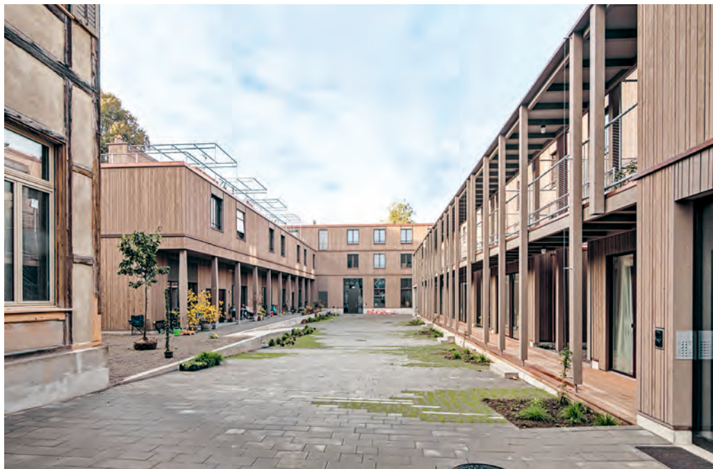
Das Laubenganghaus (rechts) und das Dachgartenhaus fassen die gemeinschaftliche Mitte der Siedlung.
